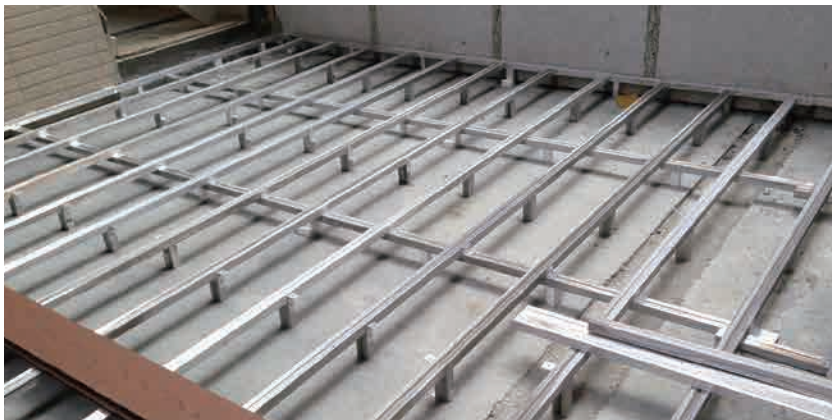
写真はリーガルデッキ専用のZAM合板根太と取付金具
