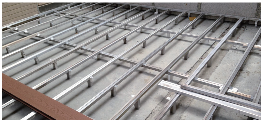
写真はリーガルデッキ専用のZAM合板根太と取付金具
