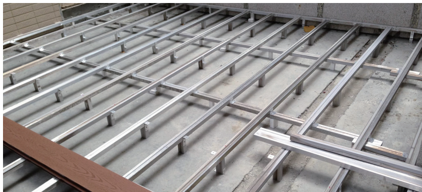
写真はMokuXia専用のZAM合板根太と取付金具
